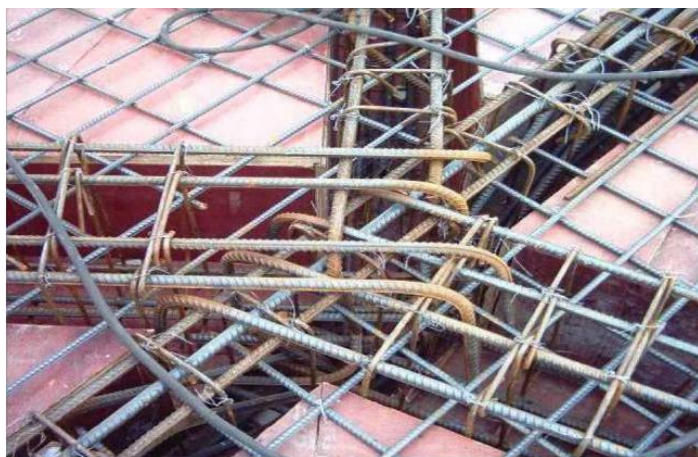
5-3 某梁节点处的钢筋交叉
